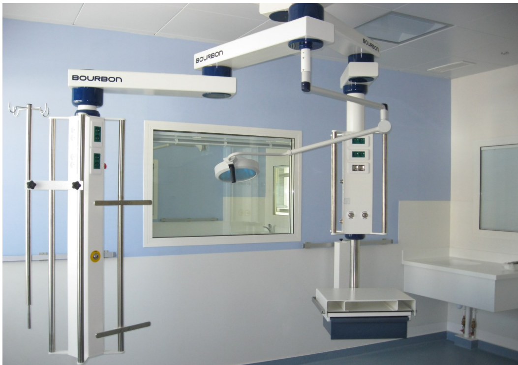
CH de Périgueux - Réanimation - Bras 56 McRp
